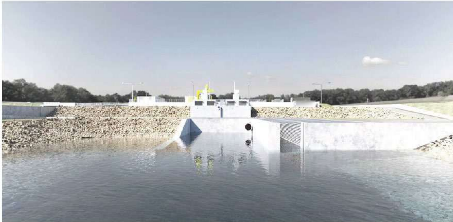
Aval de l'ouvrage et le Vieux Rhône de Caderousse
