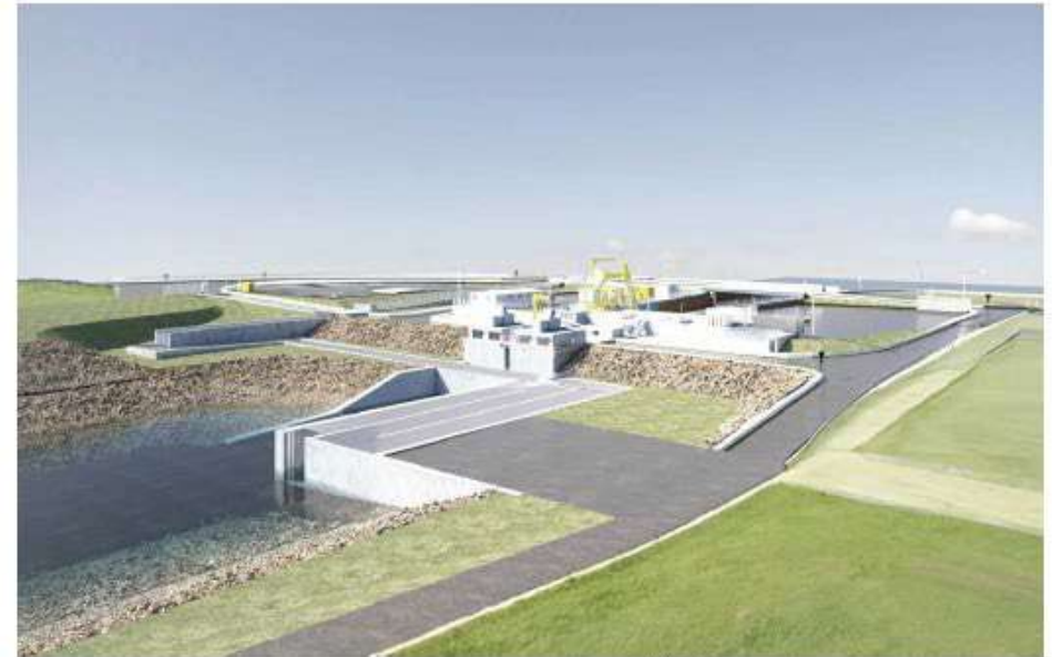
Vue depuis l'aval rive gauche et le Vieux Rhône de Caderousse
